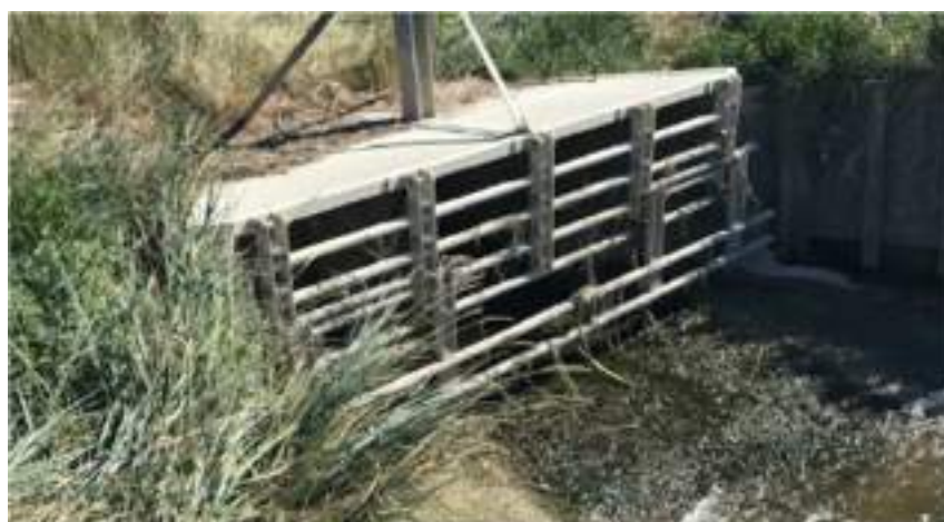
Figure 34 : Modification de l'entrée de la vanne suite à l'entrée d'un phoque
