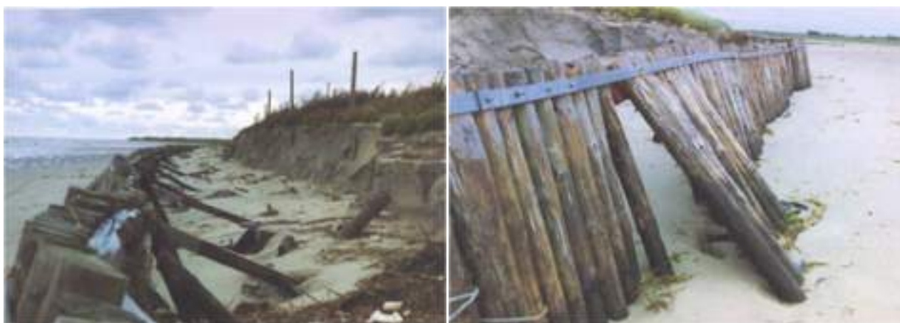
Figure 29 : Exemple de dégâts causés à la digue par des tempêtes (hiver 1992/1993)
