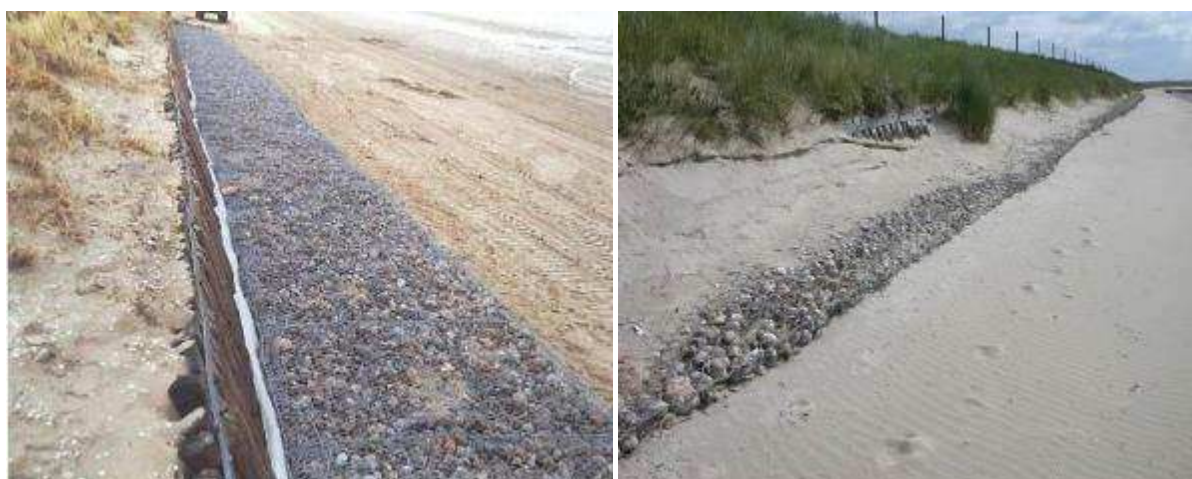
Figure 29 : Exemple de dégâts causés à la digue par des tempêtes (hiver 1992/1993)
