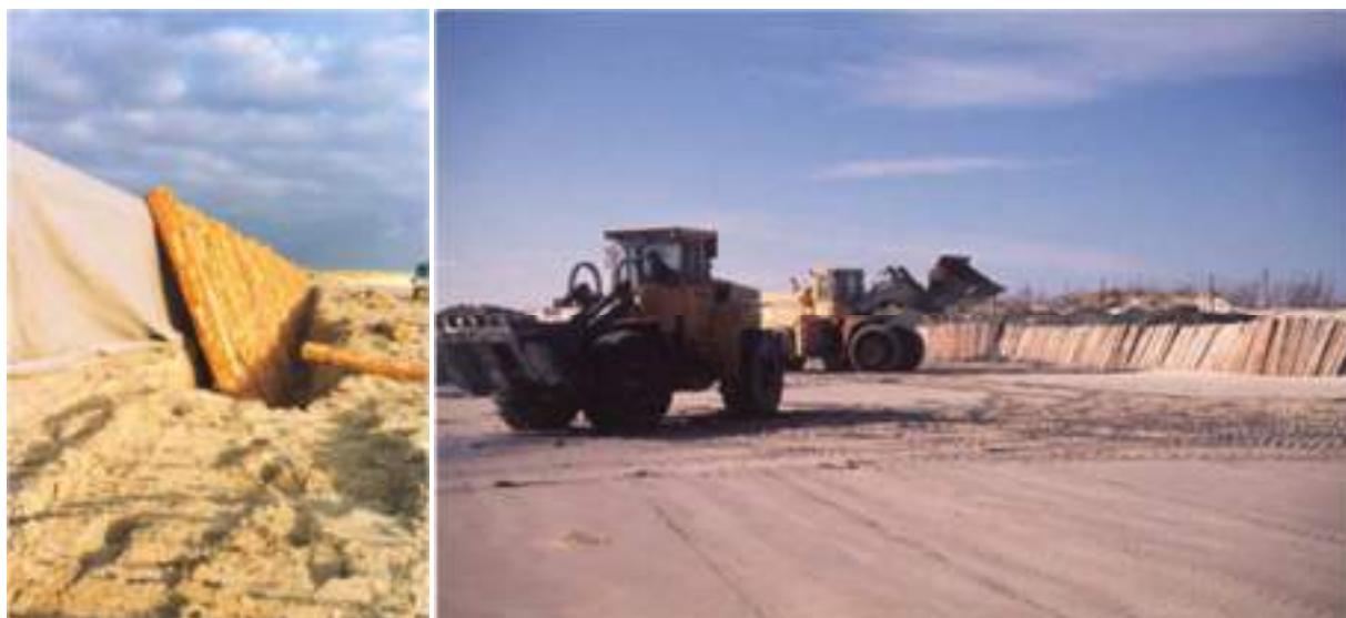
Figure 28 : Pose de rondins de pins en renforcement de la digue de sable.
