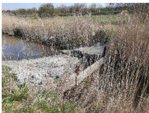
Figure 60 : Batardeau d'écoulement des eaux douces
